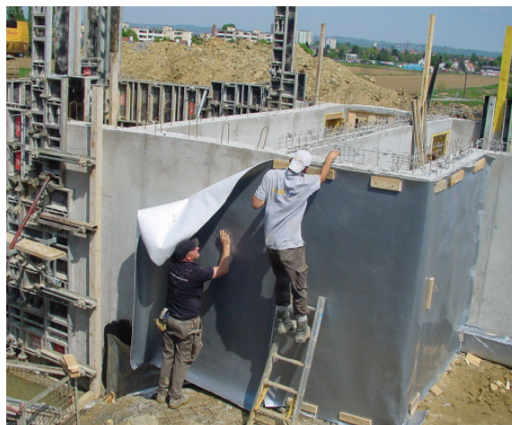
Anbringen der Abdichtungsbahnen
