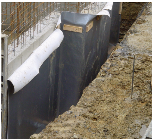
Abdichtung beim Bauvorhaben Thalerbau, Graz Fotos: BPA GmbH
