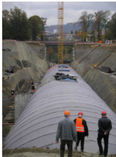
CEMtobent im Einsatz
