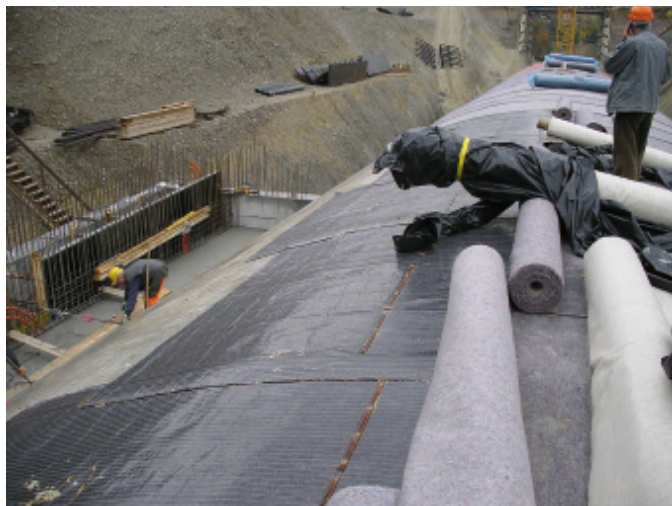
Verlegen der CEMtobent Matten
