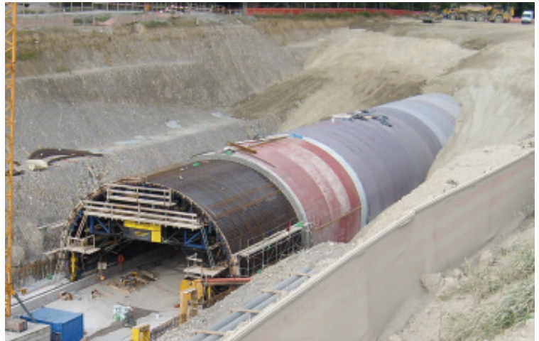
Neufeldtunnel im Bau
