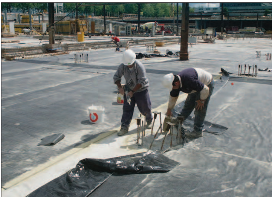
Im Wankdorf-Stadion wurde das Abdichtungssystem CEMtobent®-Bentonitdichtmatte gewählt.
