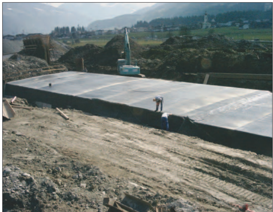
Bei Tunnelbauwerken – Tagbautunnels und Tunnels in offener Bauweise – wird das Abdichtungssystem CEMproof® bereits in grosser Masse eingesetzt.
