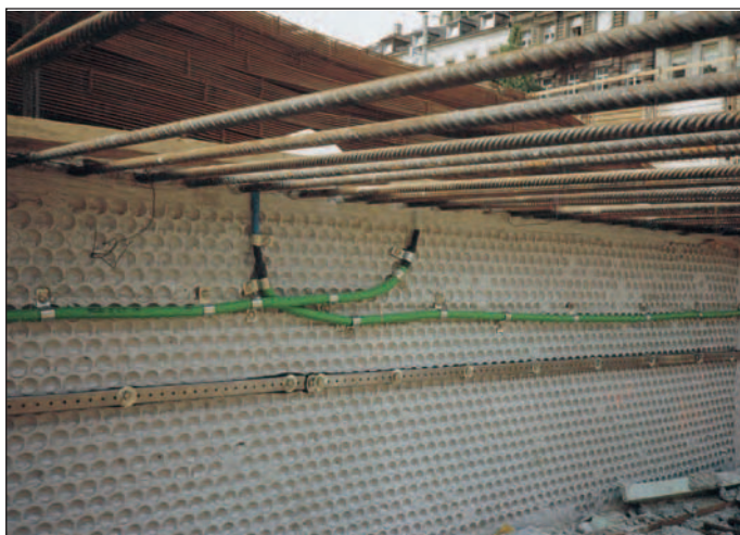
Sicherheitsfuge: Quellmax® wasserseitig, Predimax® als Sicherheit.
