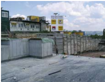
CEMtobent CS-Plus beim Einsatz auf der Tunneldecke.
